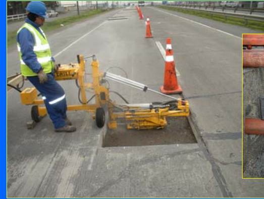
Colocación Barras de Traspaso Cargas
