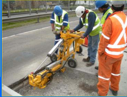
Retiro hormigón – Colocación Barras de Traspaso Cargas
