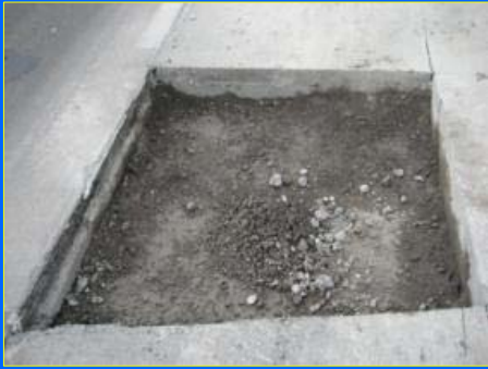
Retiro hormigón – Colocación Barras de Traspaso Cargas
