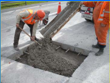
Colocación del Hormigón y Terminación Superficial
