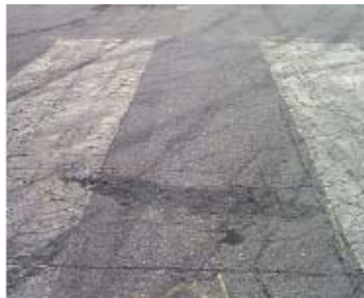
FIG. X2. 16 Bacheos mayores de baja severidad FIG. X2.17 Bacheos mayores de media
