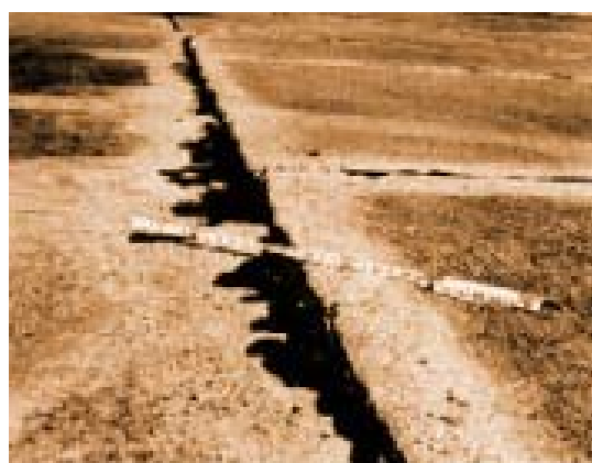
FIG. X2.25 Fallas de media severidad
