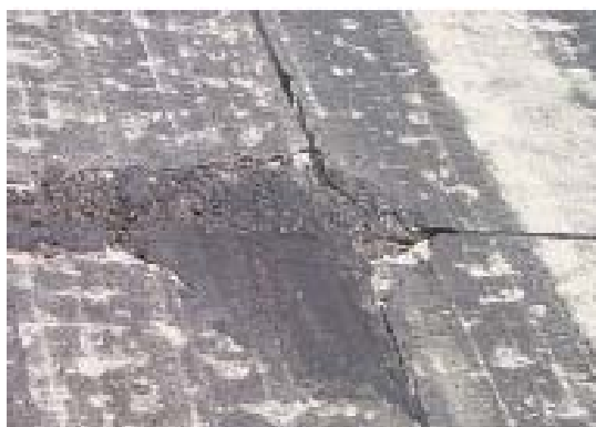
FIG. X2.15 Bacheos menores de Alta severidad
