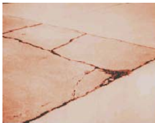
FIG. X2.28 Losa cuarteada de media severidad
