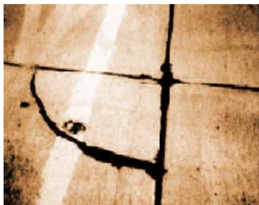
FIG. X2.1 Rotura de esquina de severidad Baja
