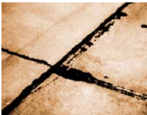
FIG. X2.34 Desprendimiento de esquina de severidad baja
