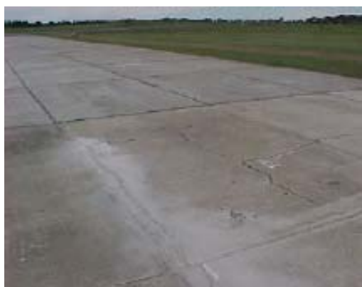
FIG. X2.27 Losa Cuarteada de baja severidad
