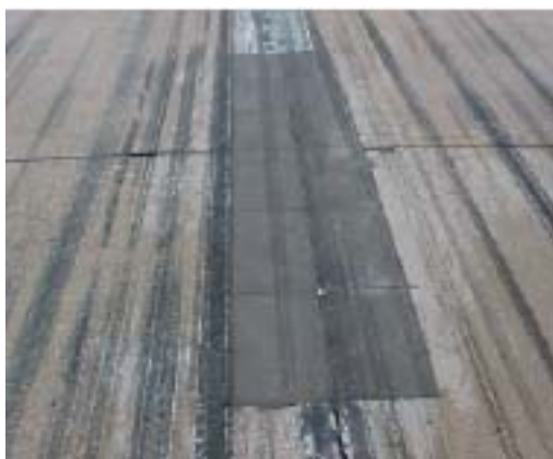
FIG. X2. 16 Bacheos mayores de baja severidad FIG. X2.17 Bacheos mayores de media
