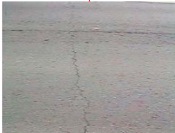
Reflexión de juntas de Baja Severidad Low Severity reflection cracking
