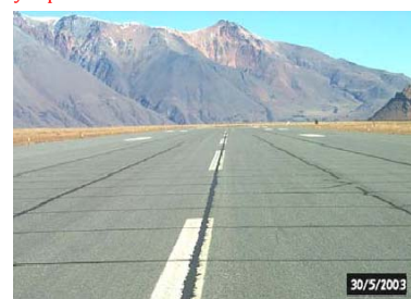
Reflexión de juntas de Baja Severidad Low Severity reflection cracking
