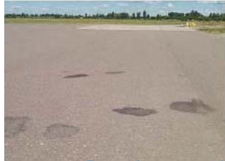
Deterioro por derrame de combustible Fuel Spillage
