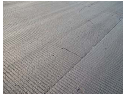
Contaminantes – Acumulación de caucho en Pista Contaminants – Rubber Accumulation on Runway
