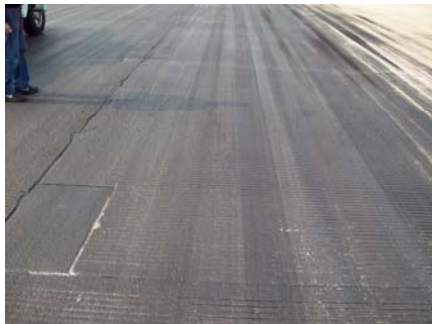
Contaminantes – Acumulación de caucho en Pista Contaminants – Rubber Accumulation on Runway
