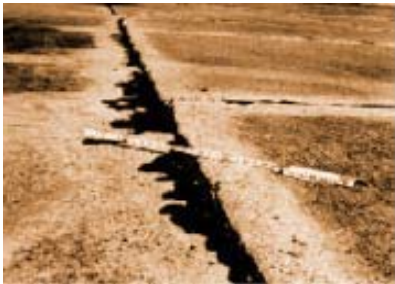
Asentamiento/desnivel de Severidad Media
