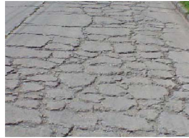
Mapa de fisuras de Severidad Baja Mapa de fisuras de Severidad Alta
