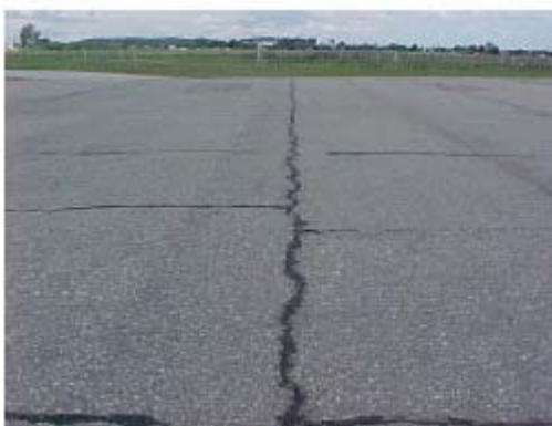
FIG. X1.18 Reflexión de junta de severidad Media
