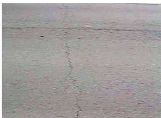
FIG. X1.17 Reflexión de junta de Baja severidad
