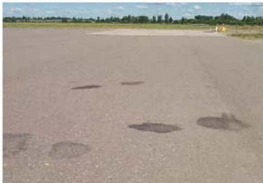
FIG. X1.23 Deterioro por derrame de combustible
