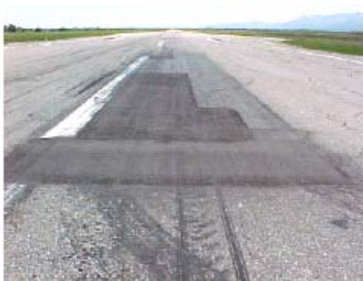
FIG. X1.24 Bacheo de Baja severidad.
