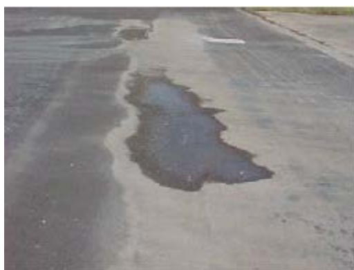
FIG. X1.13 Depresiones de severidad Media
