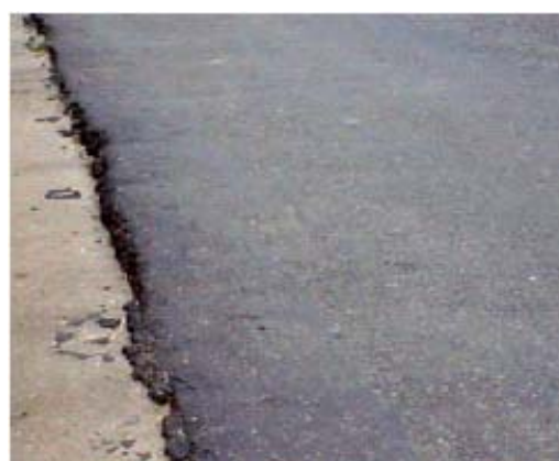
FIG. X1.35 Empuje de Media Severidad
