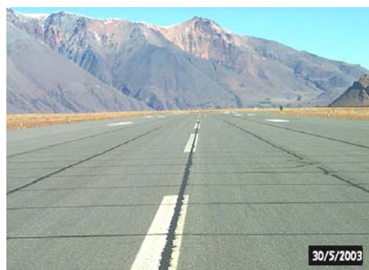
FIG. X1.17 Reflexión de junta de Baja severidad
