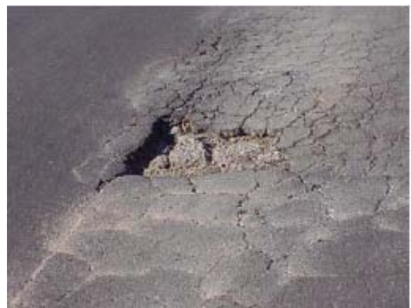
FIG. X1.3 Piel de Cocodrilo de Alta severidad
