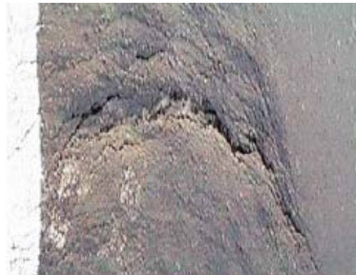
FIG. X1.38 Deslizamientos
