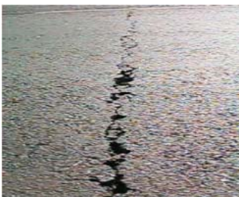
FIG. X1.19 Reflexión de junta de Alta severidad
