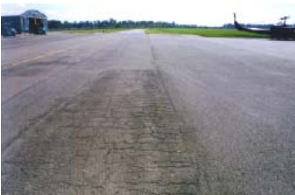
FIG. X1.2 Piel de Cocodrilo de severidad Media
