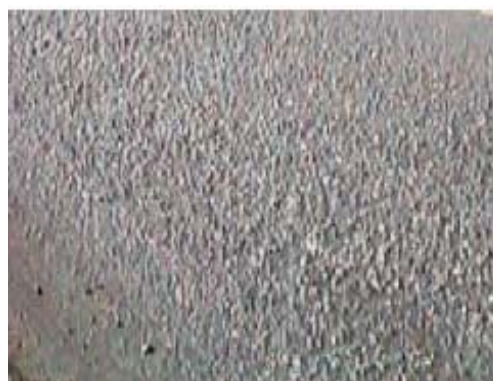
FIG. X1.29 Peladura de severidad Media
