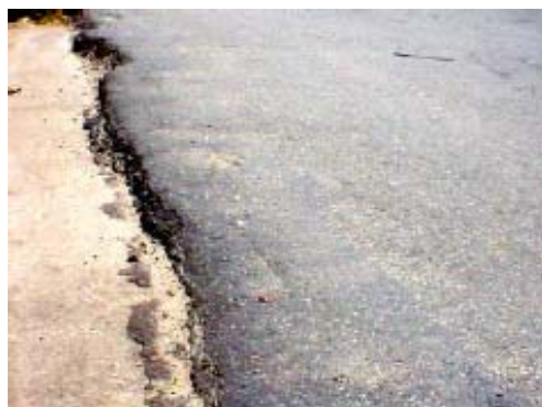
FIG. X1.36 Empuje de Alta Severidad
