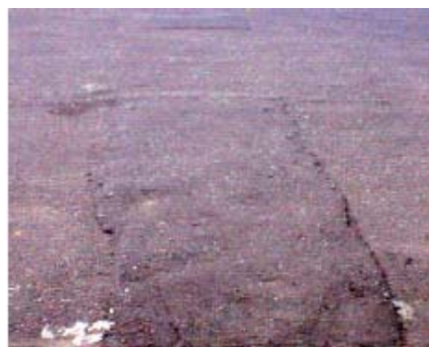
FIG. X1.40 Hinchamiento de severidad Media
