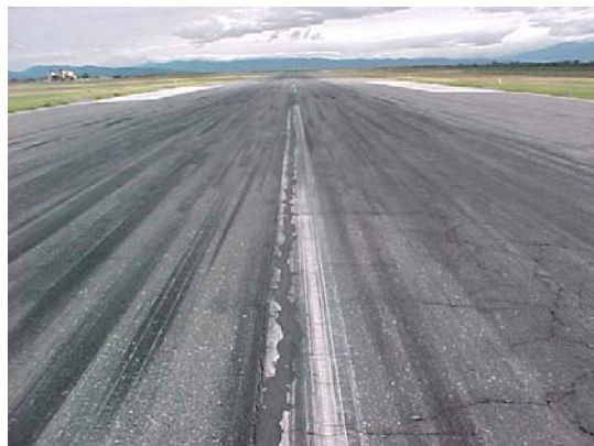
FIG. X1.6 Fisura de Bloque de Baja severidad
