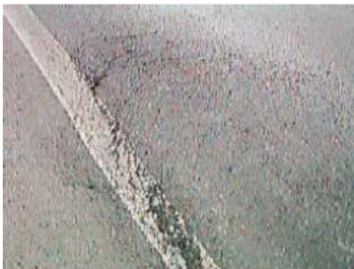
FIG. X1.37 Deslizamientos
