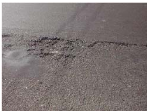
FIG. X1.30 Peladura de Alta severidad
