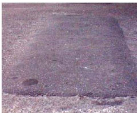
FIG. X1.39 Hinchamiento de Baja severidad
