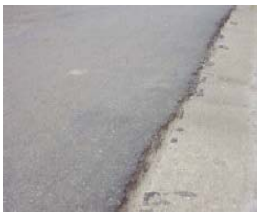
FIG. X1.34 Empuje de Baja Severidad
